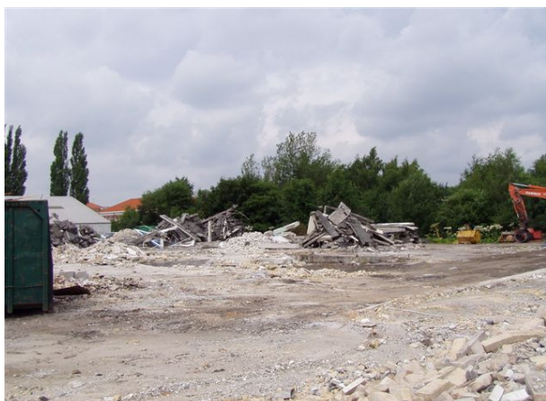
Udsortering af byggeaffald skal ske på pladsen.
