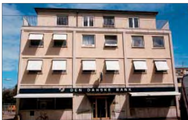
Markiser på hele facaden, tilpasset husets farve, vinduesstørrelser og husets arkitektur.
