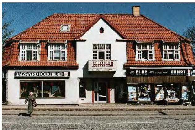
Eksempel på en husfacade før renovering. Træbeklædning og skilte deler visuelt huset op i to dele.
