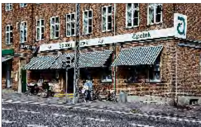
Stueetage med markiser. Her er der tale om et købstadshus, hvor en baldakin ville virke tung og „skære“ huset over. Med markiserne opnås en effektiv solafskærmning, der klæder huset.
