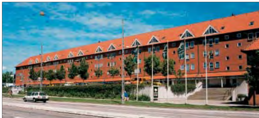
Høje Søborg Øst med trappeanlæg og hævet parkeringsareal.
