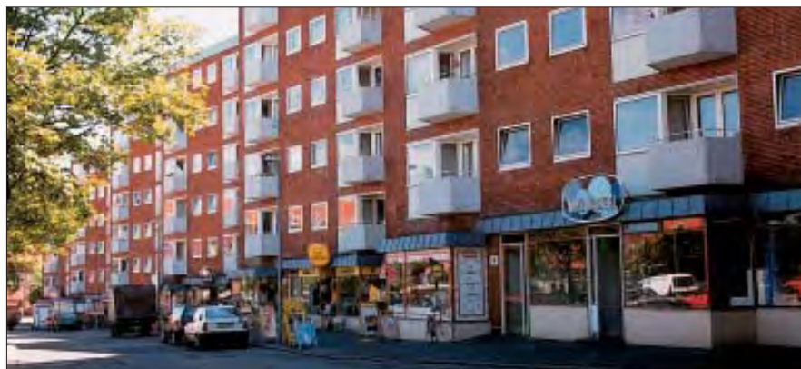
Søborg Torv, bygning II.
