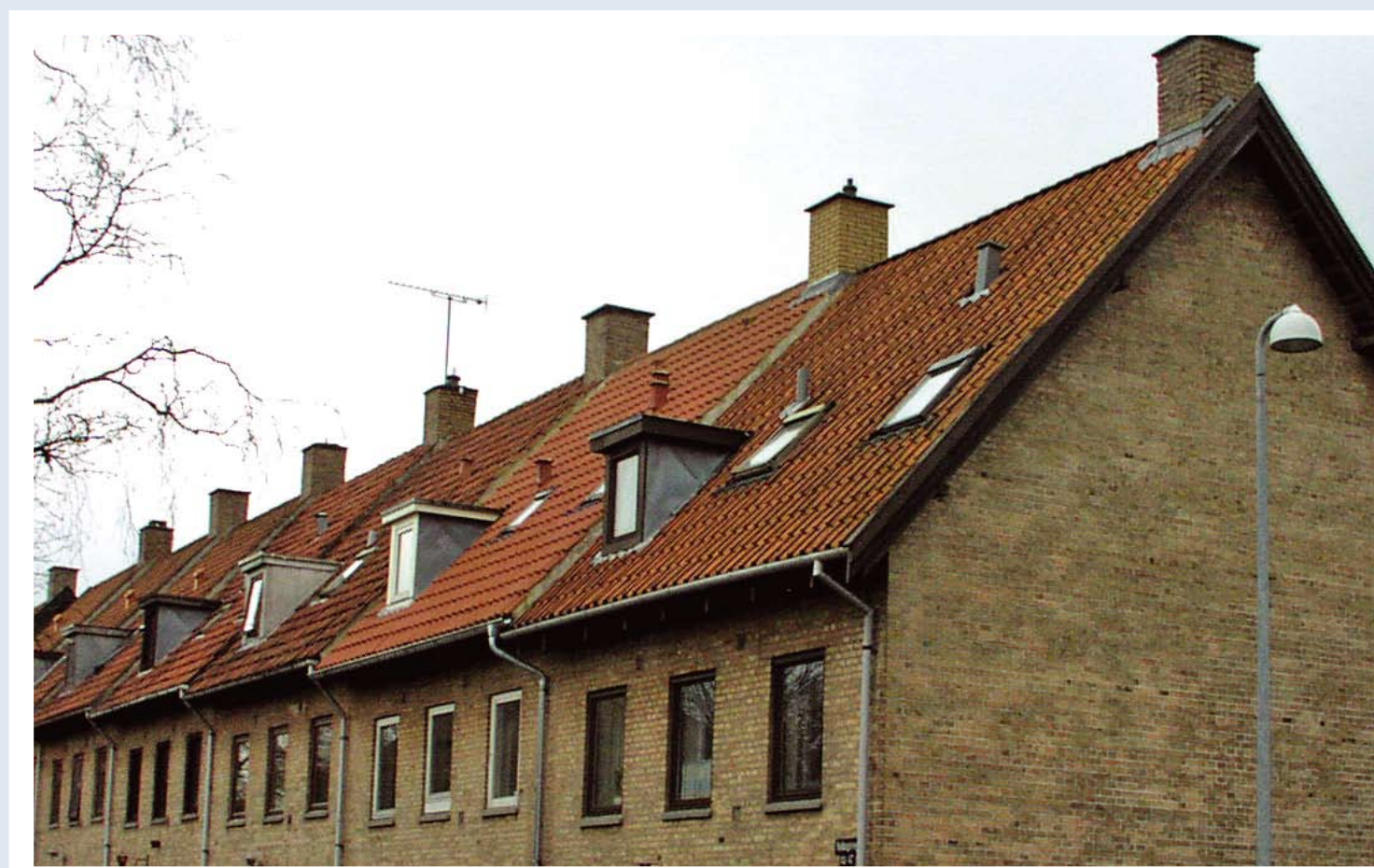
Rækkehuse hvor tagfladen i hvert enkelt rækkehus er adskilt på grund af niveauforskel.
