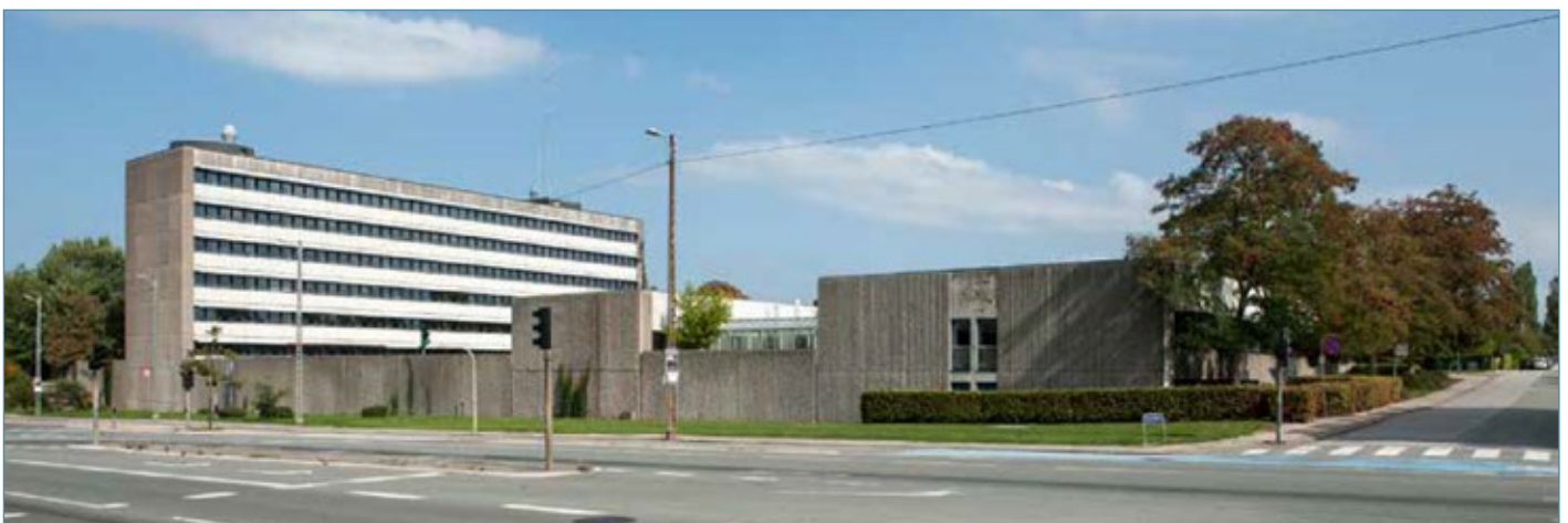
DEN EKSISTERENDE POLITIBYGNING SOM GENANVENDES, STØTTEMUREN SOM FJERNES SAMT TRÆERNE LANGS FREMTIDSVEJ
