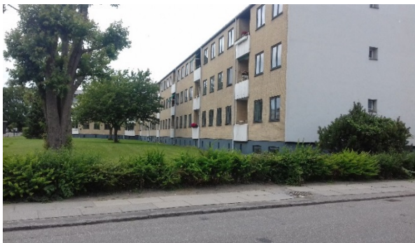
Eksempel på friarealer uden adgang fra stueetagen, Pileparken
