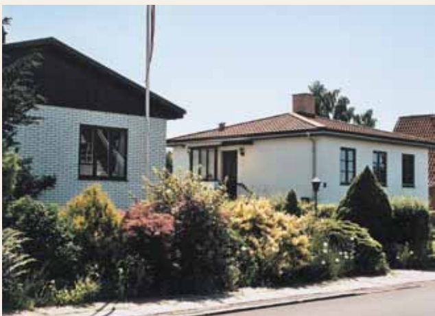
Husnummer 27 og 31 i 2006. Nummer 27 har fået skalmur. Oprindeligt var det pudset. Nummer 31 ser til gengæld næsten ud, som da det blev bygget, altså set udefra.
