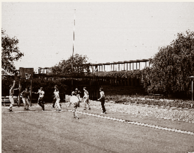
Børn på boldpladsen, 1981. De lange vinduesflader i facaden er ét af kendetegnene for arkitekt Jørgen Bo, som man også kan genfinde i Louisiana-byggeriet.
