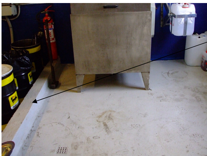
Billede 3: Opkant, der sikrer mod spild til kloak
