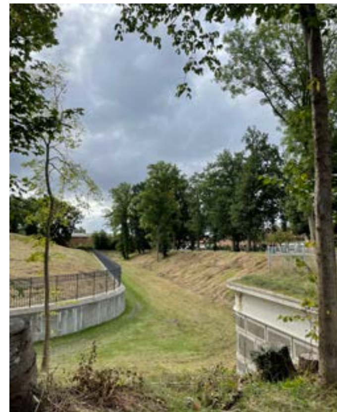
Udsigt ned mod tørgraven. Kaponieren ses til højre i billedet og fortlegeme med stormgitter til venstre.
