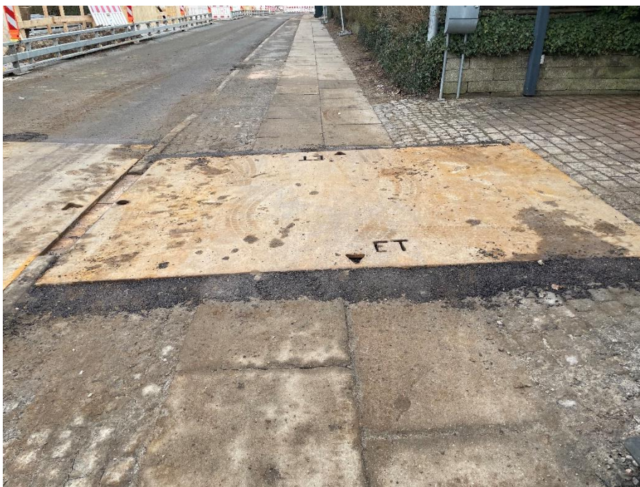
Figur 7.1 Køreplade over fortov. Kanter udjævnet med asfalt. Her burde pladen være vendt om, så hullerne i pladen ikke lå i gangbanen.
