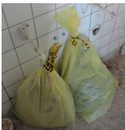
Poser med asbestaffald mærket "asbest"
