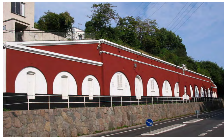
Referencefoto: Beboelseshus på toppen af Christiansholmsfortet, som genanvender og overbygger dele af den tidligere militærstruktur, Arkitekt Mogens Lassen.
