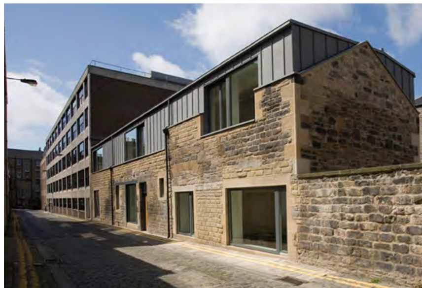
Referencefoto: Nye kontorer indbygget i eksisterende bygninger. Young Street Lane Offices, Malcolm Fraser Architects.
