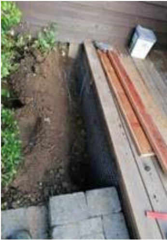
Sikring langs husmuren.
