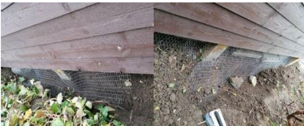
Sikring rundt om træterrassen.
