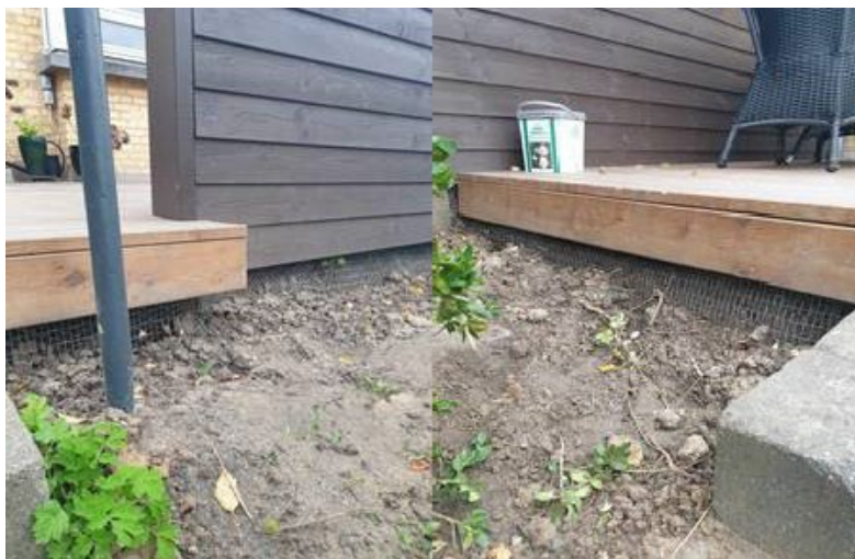
Sikring rundt om træterrassen.
