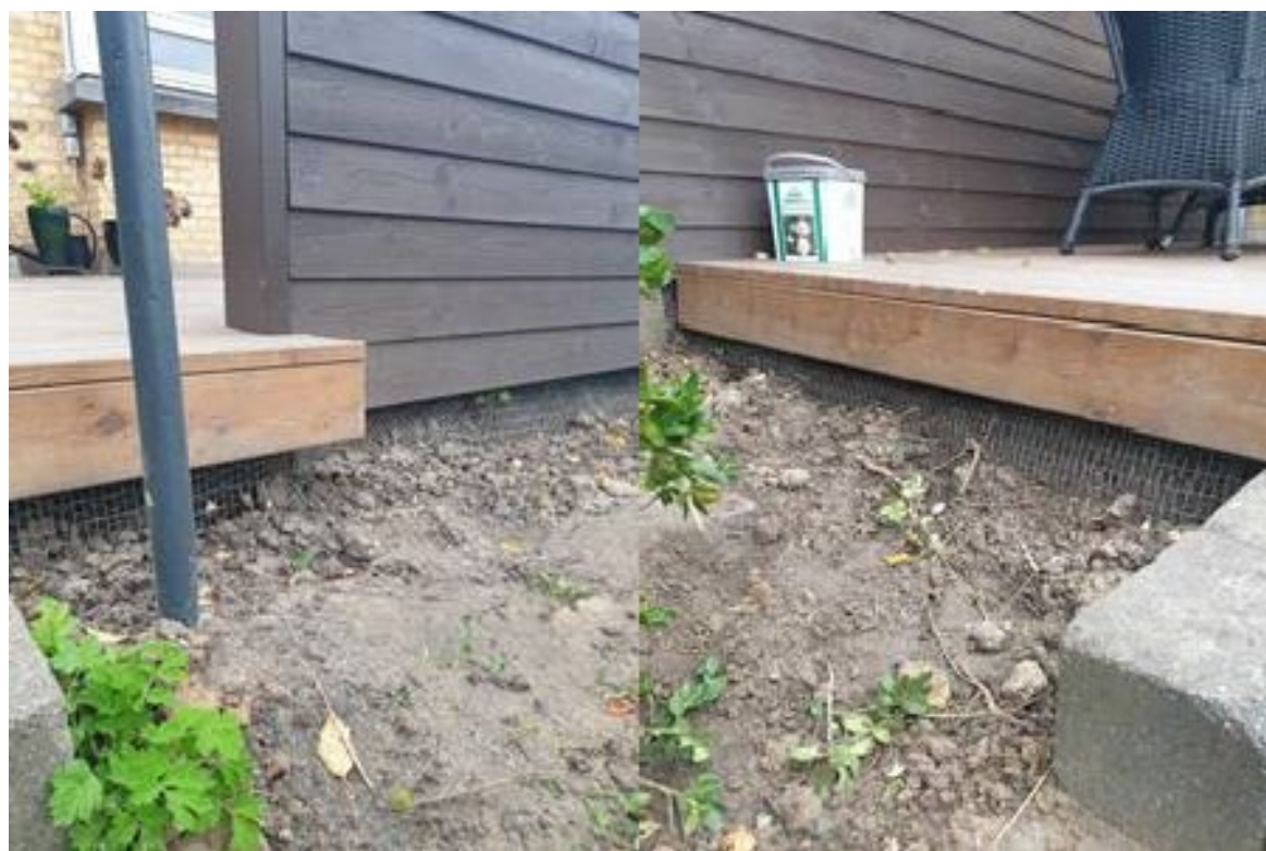
Sikring rundt om træterrassen.
