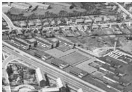
Gladsaxe Gymnasium. I 1956 blev Gladsaxe Gymnasium og folkeskolen Buddinge skole opført på arealet mellem Buddingevej og Buddinge Hovedgade
