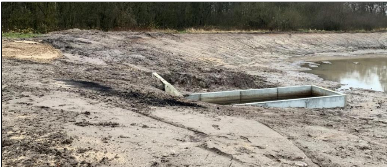
Figur 2: Sandfang i tørlagt bassin.
