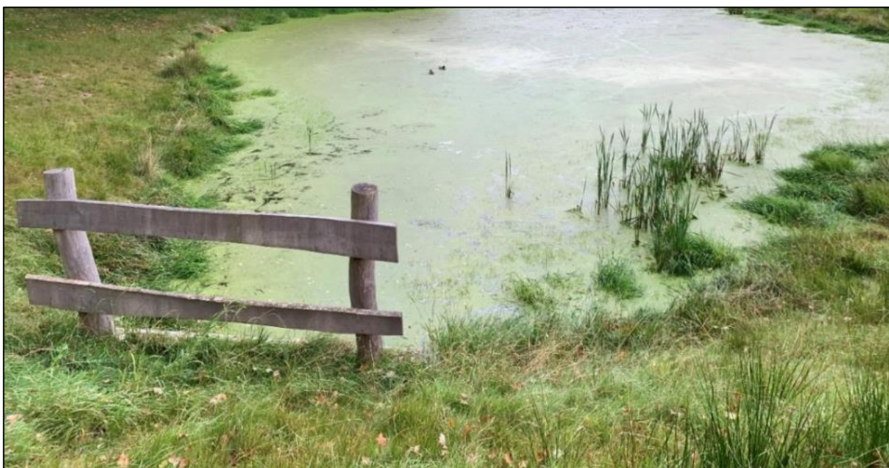
Figur 3: Sandfang ved normal vandstand med faldbarriere foran af naturtræ (robinie).
