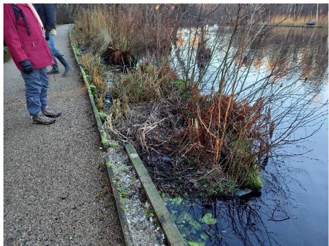
Figur 1 oplagt placering af passage. Hele brættet foran personen i rød jakke kan fjernes.
