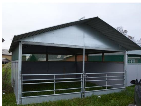
Figur 3. Midlertidigt læskur (minus frontelementer på foto)
