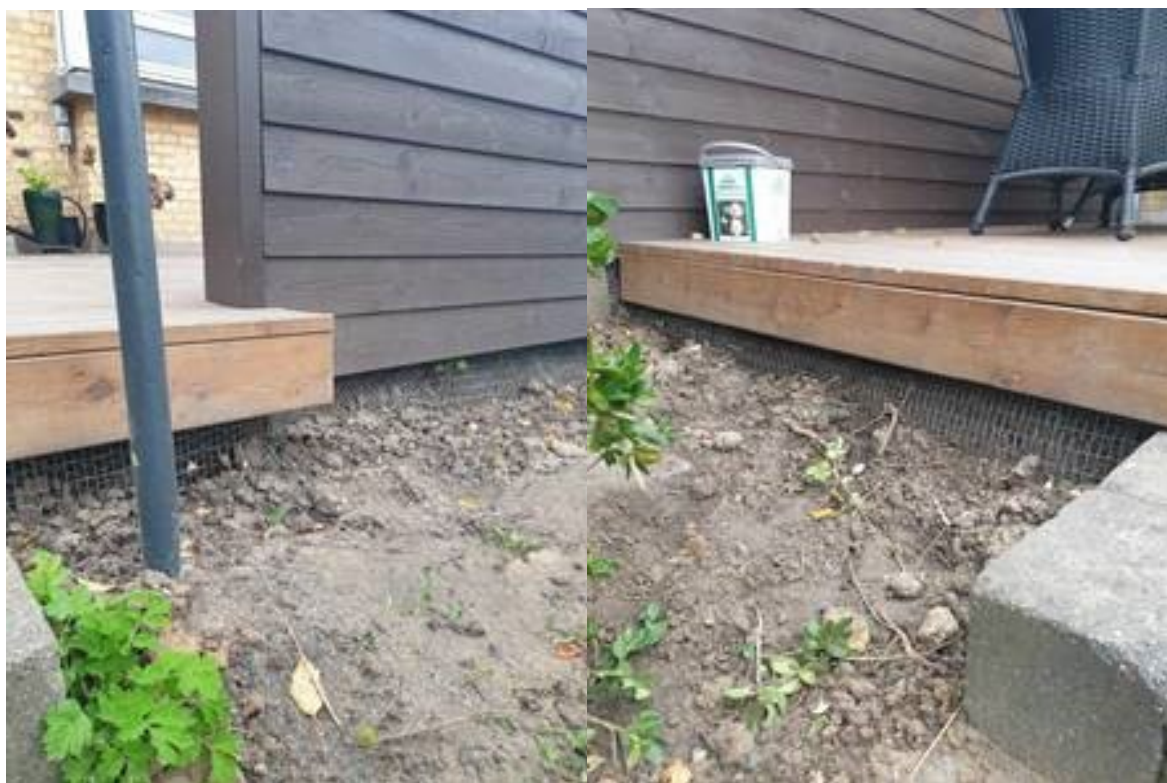
Sikring rundt om træterrassen.
