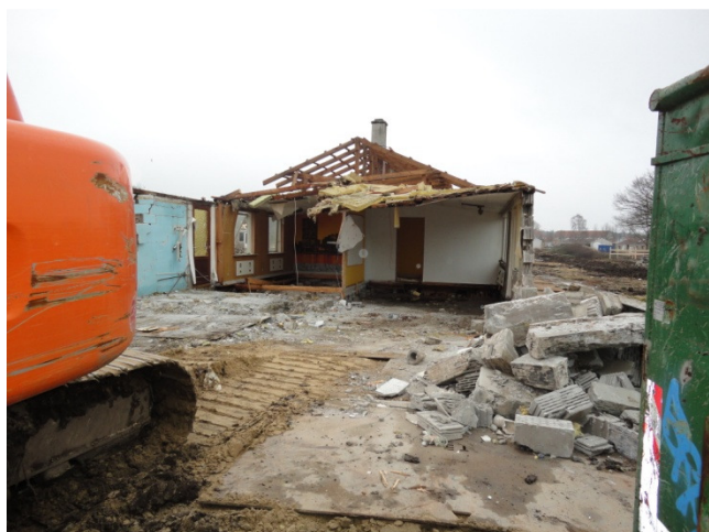
Udsortering af byggeaffald skal ske på pladsen.
