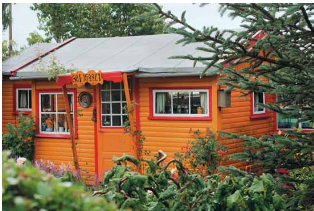
Huset på Lærkevej 149 er et af de ældste i haveforeningen 4. juli 1917. Det stammer fra 1947, og blandt byggematerialerne kan man genkende de små, hårde brædder fra datidens sildekasser og brædder fra gamle skibsvrag, som kan genkendes på, at der står navne fra andre verdensdele på træet. Anette Degn Beck købte huset omkring 1997, efter at have stået på venteliste i 1½ år. Det første, hun gjorde, var at ændre husets farve fra svensk-rød til solgul.
