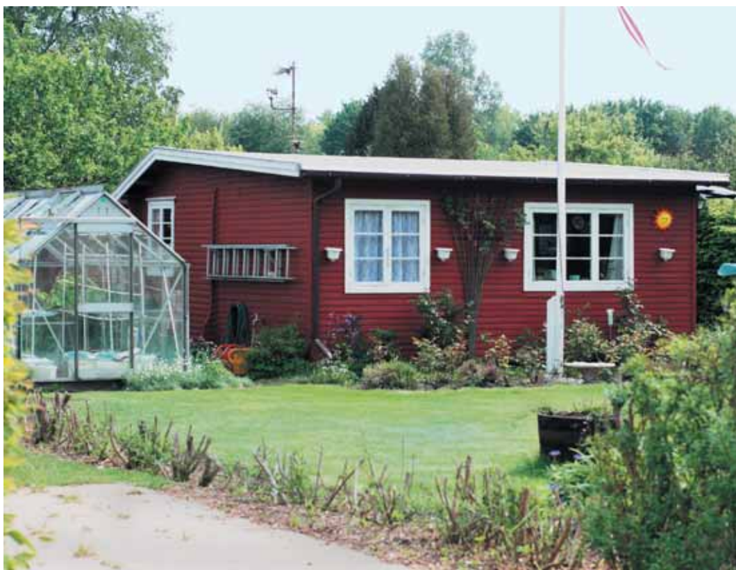
Bellisvej 138 i Smørmosen er vokset efter knopskydningsprincippet. Udspringet på væggen i venstre side viser, hvortil huset oprindeligt gik.
