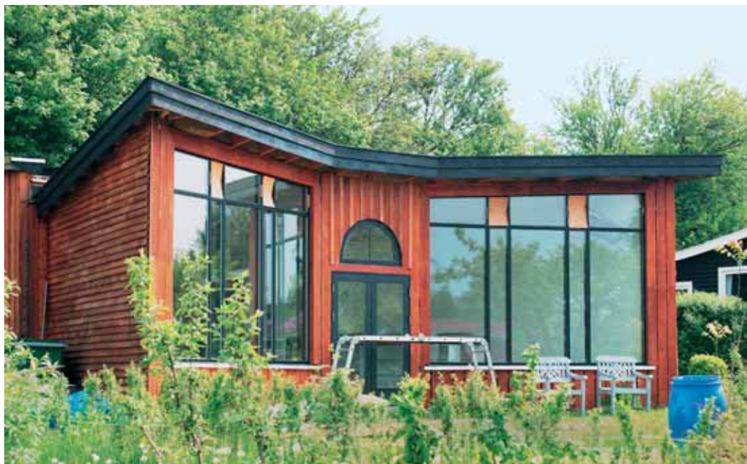
Dahliavej 62 i Smørmosen er bygget af en kreativ tømmelærling. For ikke at overskride de fire meter i højden, ligger noget af stueplanet under jordhøjde. Men huset har to etager og tagterrasse og overholder samtlige bygge regler!
